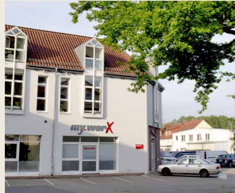
Zentral gelegen: der neue Standort der my.worX-Abteilungen digital media und logistik in der Groner Landstr. 23/25
